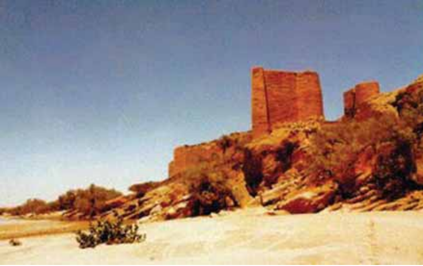
Resimde yıkıntıları bulunan Mağrib barajı görülüyor. Sebeliler barajın yıkılması sonucunda büyük zarara uğradılar, barajın suları bahçelerini mahvetti.
